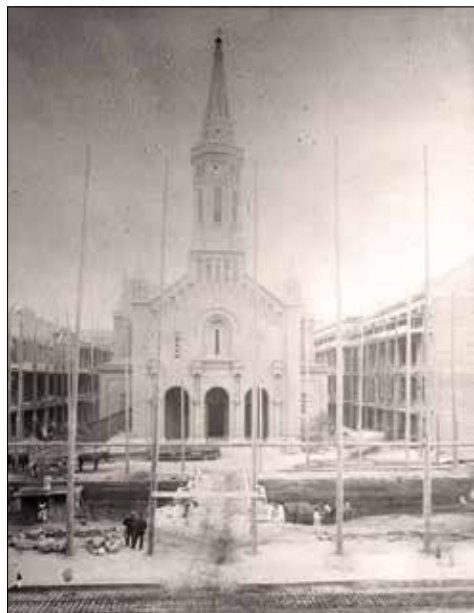
Épülő bérházak a templom körül (1890 körül) • Stavba nájomných domov okolo kostola (okolo roku 1890)
