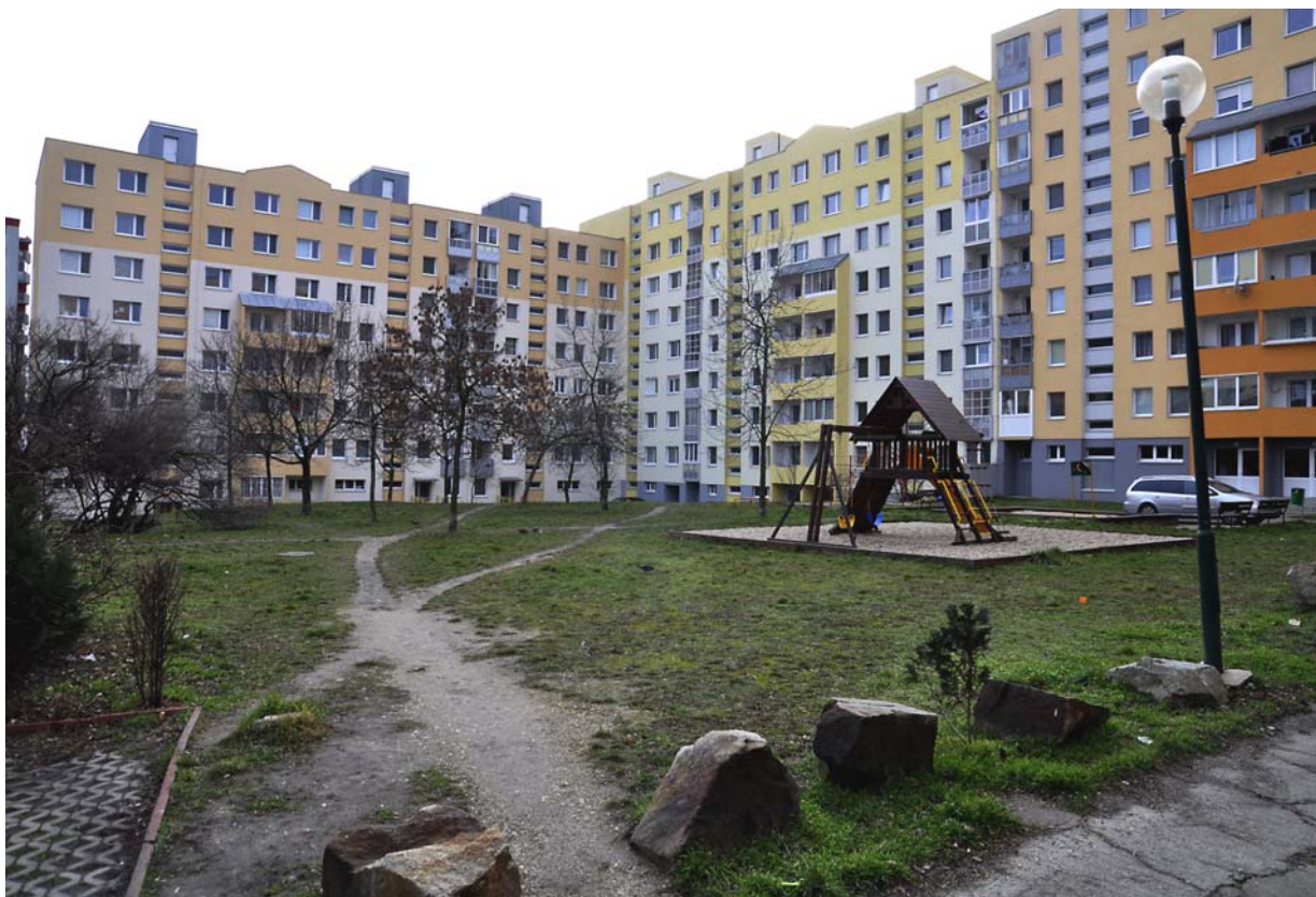
Obr. 5: Súčasný stav vnútroblokových priestorov pôvodnej zástavby sídliska Dlhé diely. Foto: Peter Szalay
