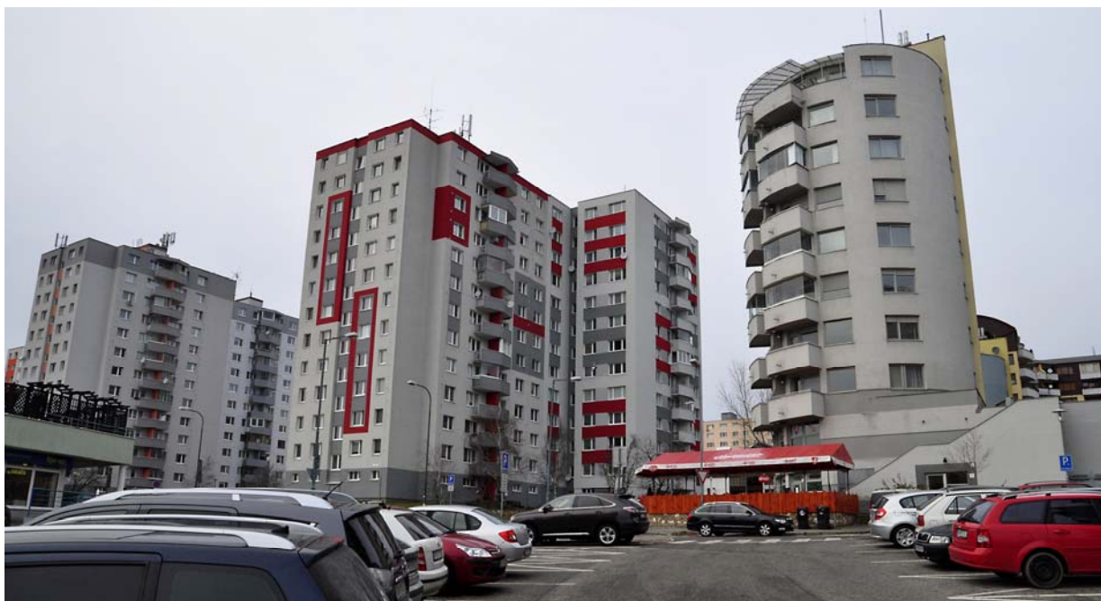
Obr. 5: Stret dvoch historických vrstiev sídliska na Jamnického ulici na Dlhých dieloch. Zatepl'ovanie je jedným zo súčasných nástrojov „humanizácie“ a zjednocovania architektonického výrazu sídliska. Foto: Peter Szalay
