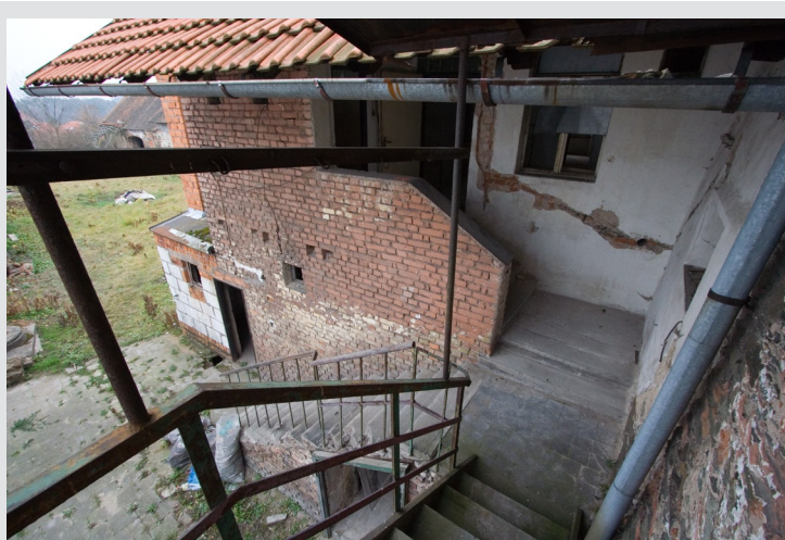
Obr. 38: Přístavba nových schodů a záchodů k severní fasádě severovýchodního křídla podle plánu z roku 1934. Přístavba nebyla nikdy omítnuta (další, již tvárniceová přístavba vlevo vzadu vznikla v 70. až 80. letech 20. století). Přístavba byla zbořena roku 2012. Foto O. Jareš, 2006.
