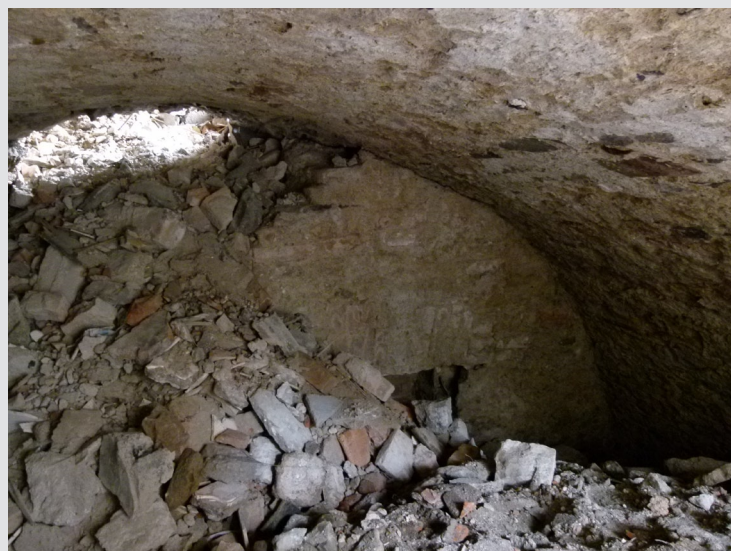
Obr. 15: Torzo rozsáhlého sklepa pod severním křídlem. Sklep S04, pohled k západu. Severní sklepy je možné označit za ležácké pivovarské, blíže neurčitého obecně „barokního“ stáří. Sklep na snímku by mohl být ještě i ze 17. století. Klenba zbořena roku 2012.
