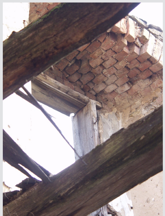
Obr. 13: Cihly vysokého formátu charakteristické pro období „budovatele – obnovitele“ domu i tvrze Materny z Eisenachu krátce po roku 1690. Na snímku jedna ze tří nik v chodbě S01 za sklepní šíjí. Cihly jsou totožné s cihlami použitými na spolehlivě datované přestavbě tvrze.
