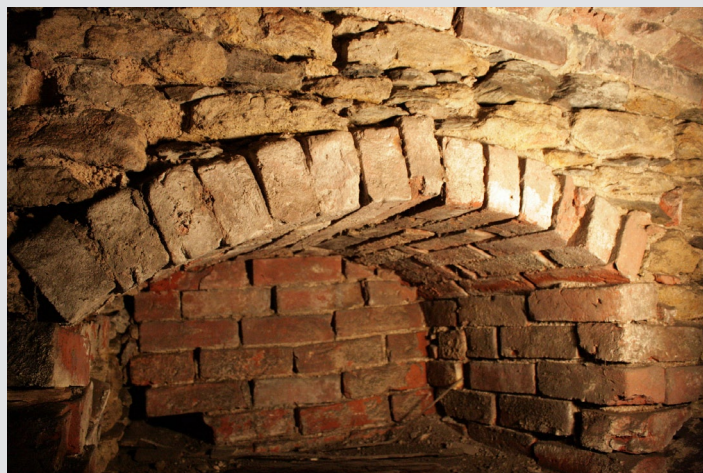
Obr. 13: Cihly vysokého formátu charakteristické pro období „budovatele – obnovitele“ domu i tvrze Materny z Eisenachu krátce po roku 1690. Na snímku jedna ze tří nik v chodbě S01 za sklepní šíjí. Cihly jsou totožné s cihlami použitými na spolehlivě datované přestavbě tvrze.
