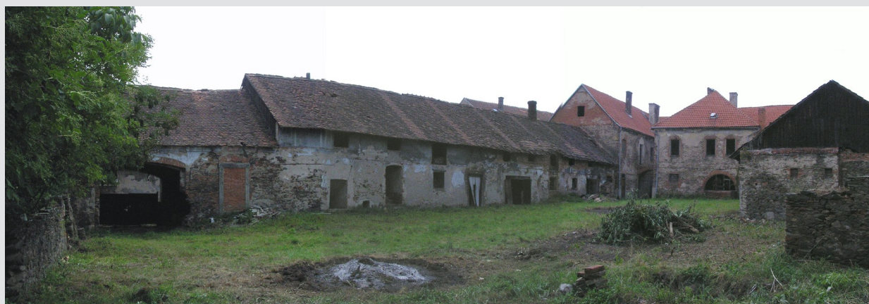
Obr. 30: Panoramatický pohled od východu ze dvora. Charakter obytného domu je určen přestavbou kolem roku 1800 a novým krovem z roku 1834, jižní křídlo z roku 1834 má novou střechu po požáru (dřevo 1885/1886), stodola vlevo byla dokončena roku 1868. Severní křídlo vpravo má vždy stigma improvizace, vzniká postupně v průběhu druhé třetiny 19. století, částečně na starších suterénech (obr. 15).
