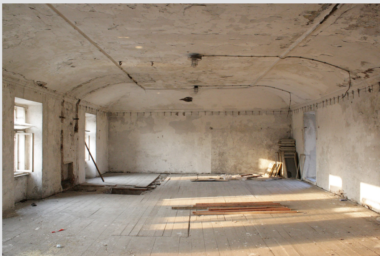
Obr. 23: Nový sál v patře severozápadního křídla, patrně z doby mezi 1803 – 1805. Celkový pohled k severu do prostoru s bedněnou klenbou. Foto O. Jareš, 2006.
