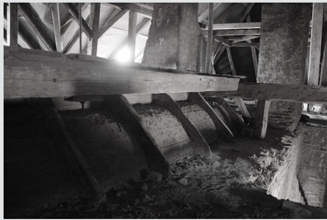
Obr. 26: Konstrukce bedněné klenby vystupující nad běžné stropy do prostoru krovu. Někdejší krov byl dokonce touto vestavbou staticky poškozen (viz obr. 24). Bedněná klenba nebyla zateplena hliněnou mazaninou ani jiným způsobem, sál tedy byl nevytápěný. Sklon jižního neckového čela na fotografii je nápadně strmější než čela severního i obou bočních podélných vzdutých ploch (viz obr. 21). Foto M. Kracík, 2011.
