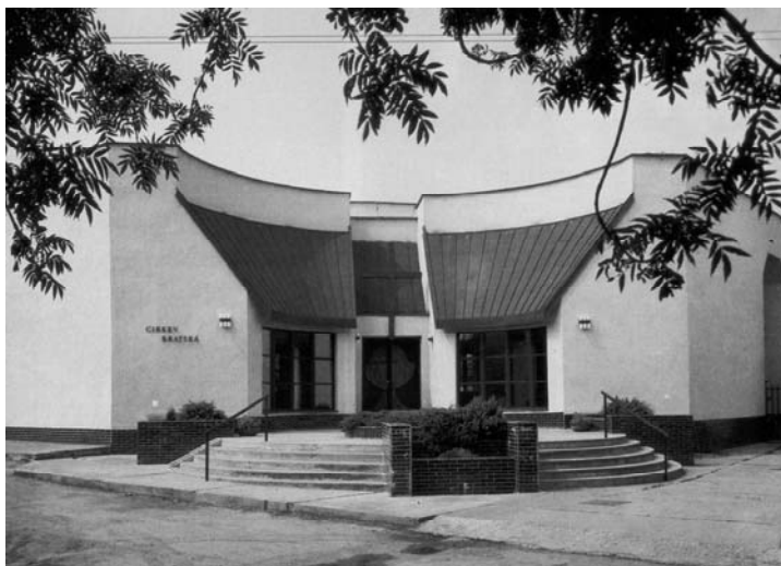
M. Žitňanský, Stará Turá, realizace (1982-83) – pohled na vstup
