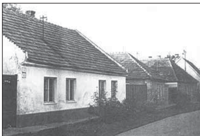
Hoferské domy z medzivojnového obdobia v Číferi, okres Trnava. Predstavujú stavebný typ redukovaného obydľia, kde prevažujú indiferentné architektonické znaky, ale ešte v nadväznosti na miestnu formu roľníckeho domu s odkvapovou orientáciou. V tomto období to bolo obydľie najnižšej sociálnej vrstvy sociálne stratifikovanej bohatej poľnohospodárskej obce.
